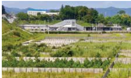
海岸沿いでは堤防のかさ上げのほか、植樹による防災、減災の取組みも行われている。
