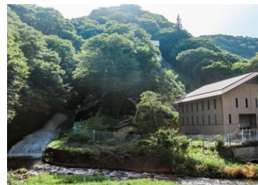
疏水の落差を活かして発電する 沼上発電所
